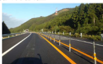
(磐越道 三川IC～安田IC) 延長0.4km
