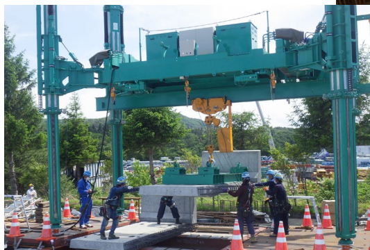
◀床板取替用架設機
