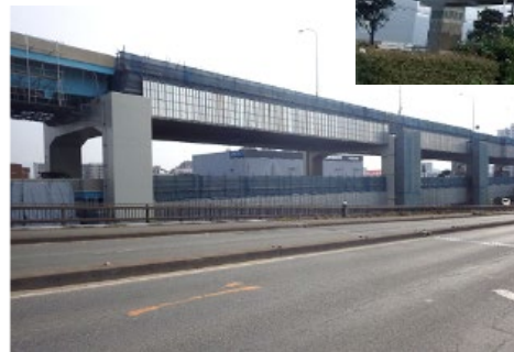
◀箱崎～東浜補修工事
