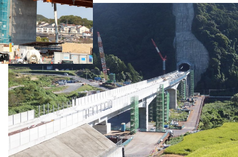
彼杵川橋りょう ▶
