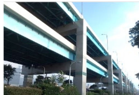
貝塚JCT～箱崎橋梁補修工事▶
