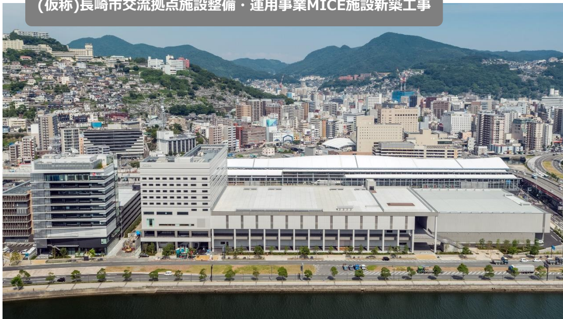
(仮称)長崎市交流拠点施設整備・運用事業MICE施設新築工事
