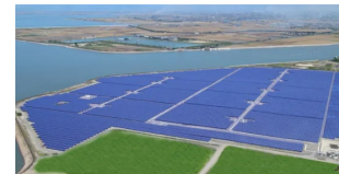
福岡県みやま市太陽光発電所
