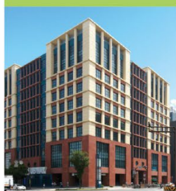
呉服町ビジネスセンター
