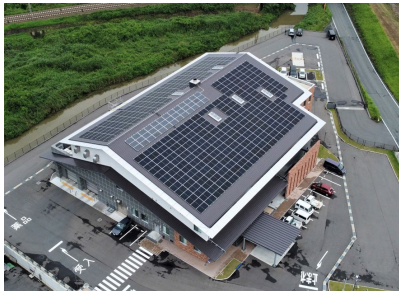
▲直方市汚泥再生処理センター
