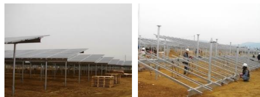
太陽電池アレイ支持架台設置工事
