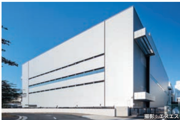
キャノン株式会社平塚事業所 H棟建設工事（神奈川県）
