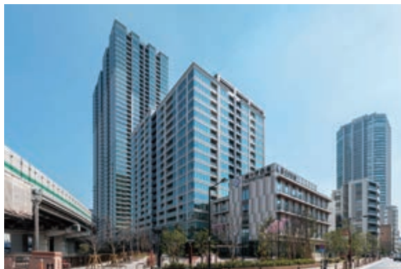
白金ザ・スカイ新築工事（東京都）
