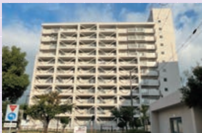
西宮真砂高層住宅
