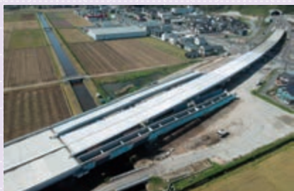
浦富高架橋 (4工区) (鳥取県岩美郡岩美町)
