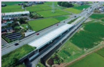
柳瀬大橋右岸アプローチ橋 (福岡県柳川市)
