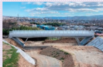
国分地区跨道橋 (長野県上田市)
