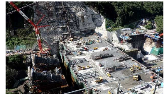
ハツ場ダム建設現場
