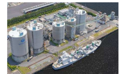
東京サービスステーション
