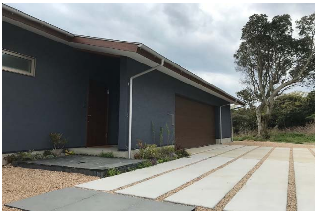
戸建て新築工事
