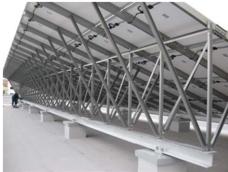
①太陽電池アレイ支持架台
