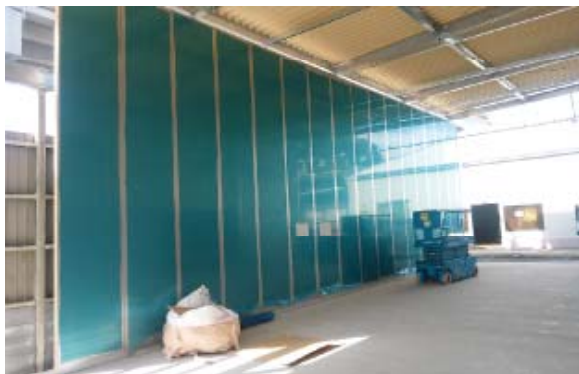
耐火/不燃断熱パネル（設計、調達、設置工事、内装仕上げ）
