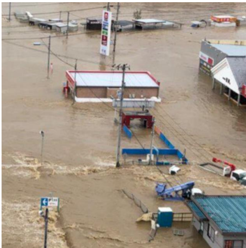
西日本豪雨により被災する当社店舗の様子（愛媛県）
