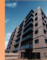
ペット共生型マンション シェリアン
