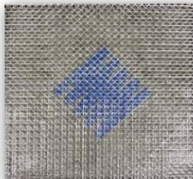
ガラス連続繊維シート貼付け・含浸
