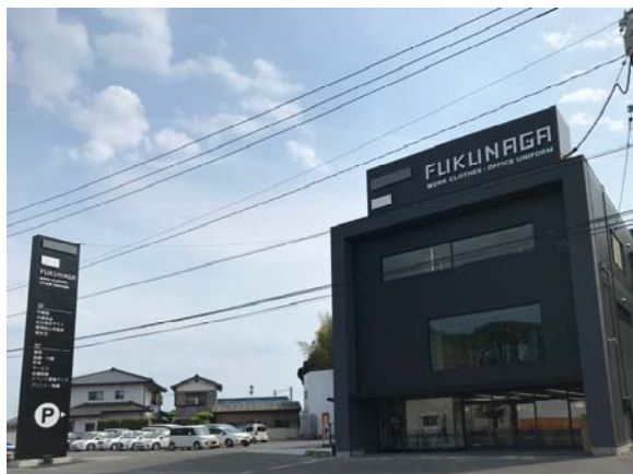
店舗改装工事（作業服・用品店）
