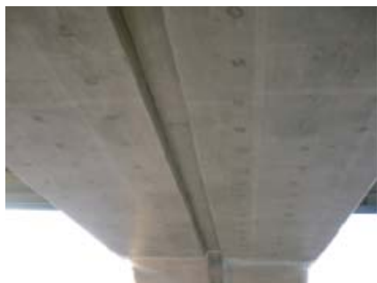
点検箇所の撮影
