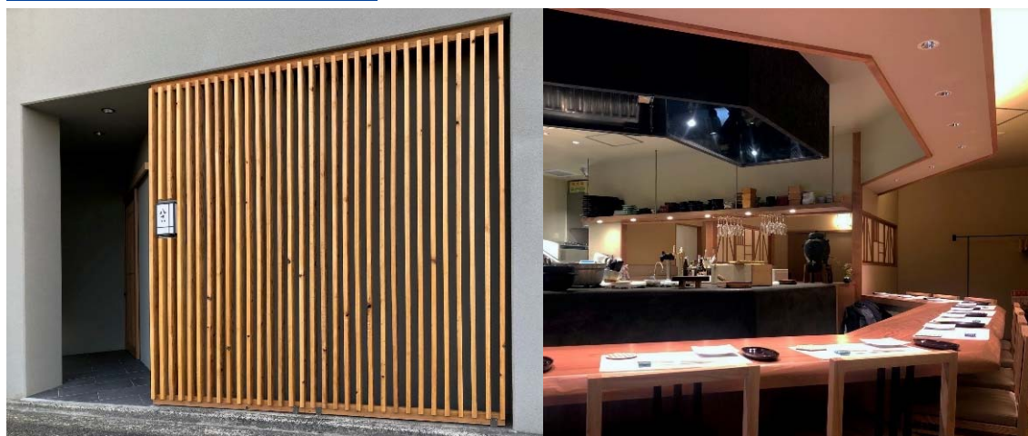
店舗新装工事（割烹）
