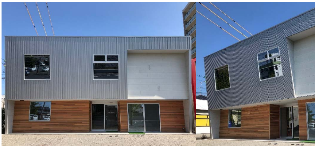
新築工事（医療器具関係）
