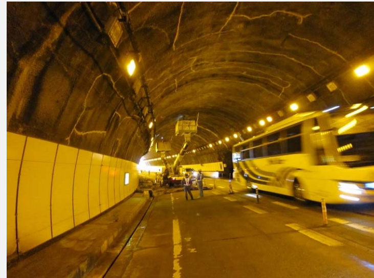
トンネル吹付けモルタル部剥落対策工事 (スケルトンクリアーコーティング)
