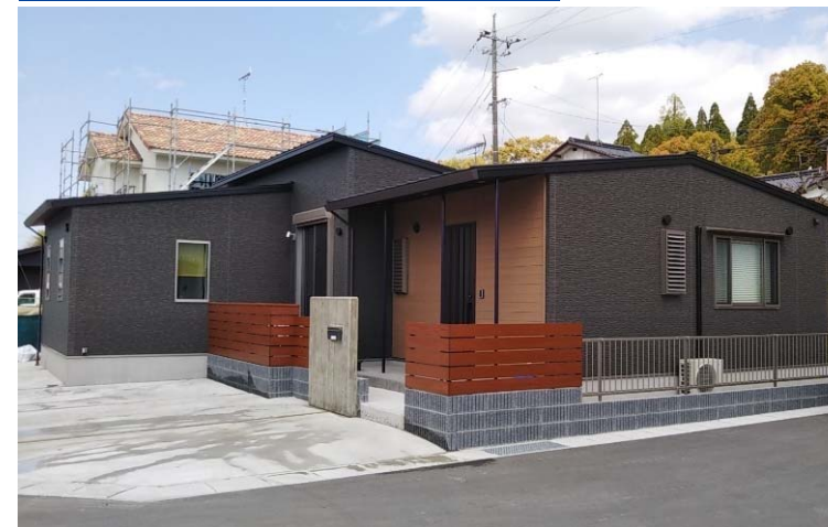
新築工事（戸建住宅）
