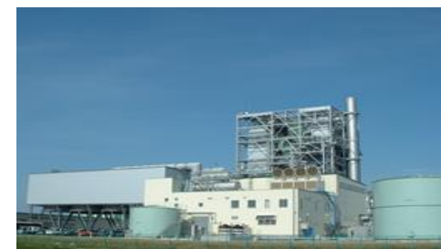
【 苫小牧発電所 】
