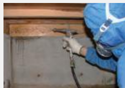
白蟻防除施工
