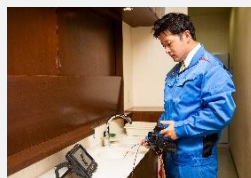
ビデオスコープによる水道管検査
